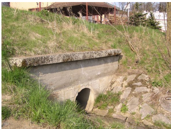
Vyústění kanalizace VAKu v km 0,055 cyklostezka povede nad
